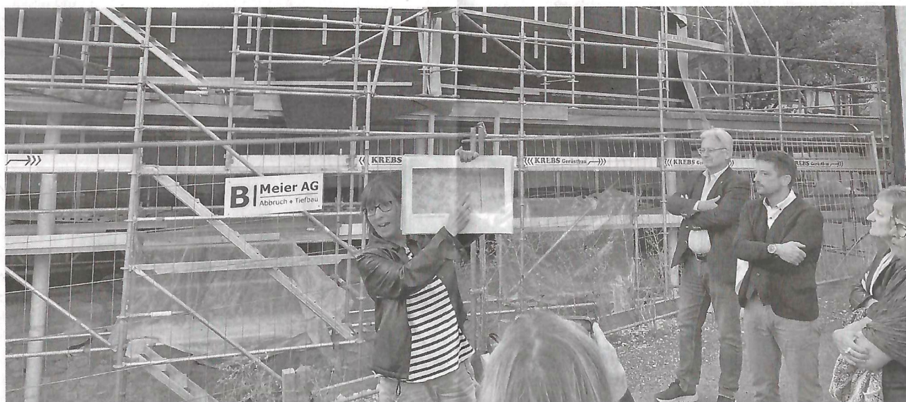
Flurina Pescatore erklärt vor dem freigelegten Wassergraben die Vergangenheit und erläutert, wie das neue Bauwerk hinzugefügt wird. (Bild: E.M.M.)
