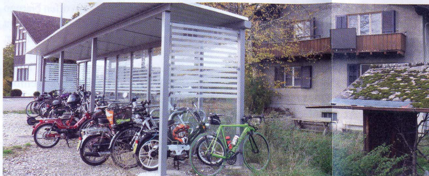
In der Beringer Bahnhofsnähe soll das Haus «Zum Bienengarten» abgerissen und ein zweiter Velounterstand montiert werden. (Bild: max)
